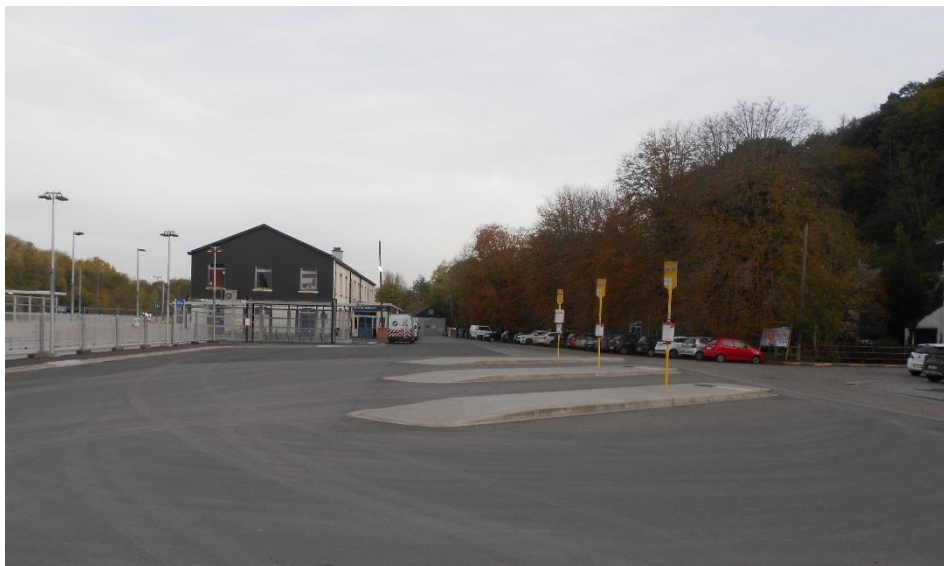
Figure 3 : Abords de la gare – arrêts TEC (photo : Dr(ea) 2 m, 2022)
