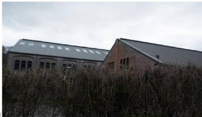
Installer des panneaux photovoltaïques sur le toit du service Travaux permettrait à la Commune d'être autonome en électricité.
