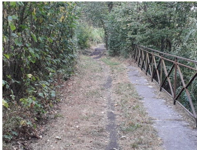
Figure 4 : Vue sur le dessus de l'aqueduc
