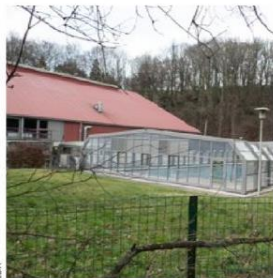
Les travaux de rénovation de la piscine devraient débuter en mars prochain.
