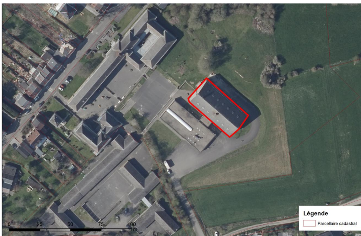
Localisation du bâtiment sur le site de Fraire – vue aérienne
