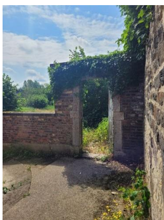
Photo 11 : accès arrière (Source : DR(EA) 2 M)
