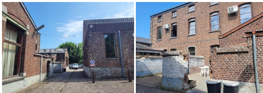
Figure 8 : Façade arrière de l'ancienne école communale (DR(EA) 2 M).
