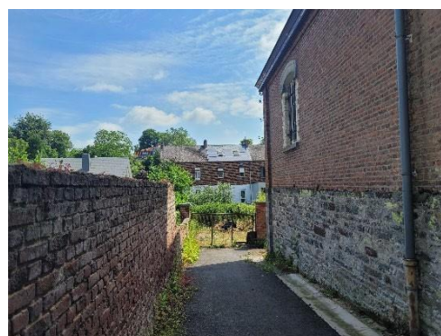
Photo 6 : accès arrière (Source : DR(EA) 2 M)
