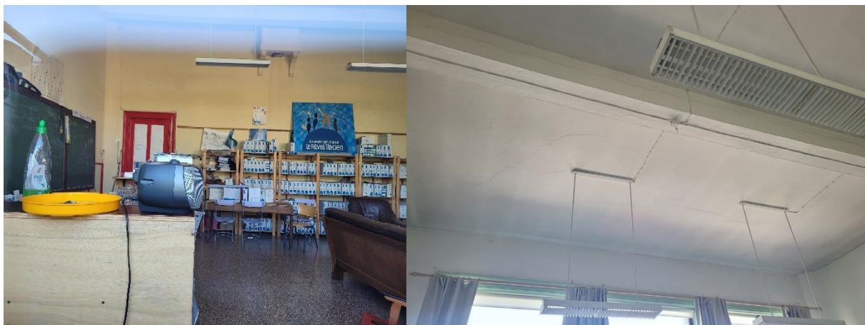
Figure 9 : Vue intérieure des locaux du rez-de-chaussée (DR(EA) 2 M).
