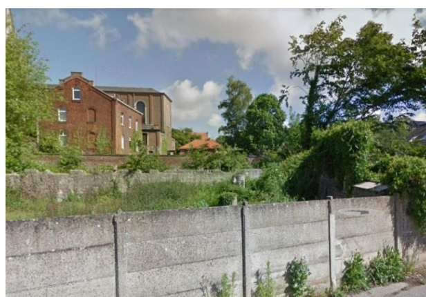
Photo 12 : vue depuis la rue arrière (Source : DR(EA) 2 M)
