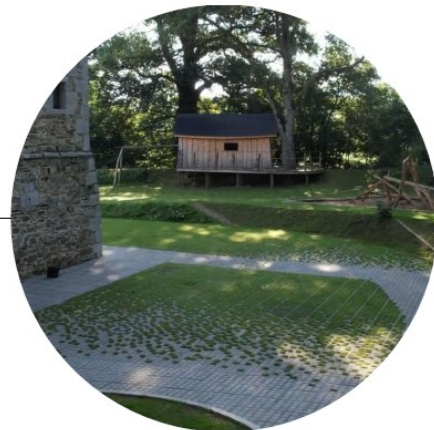
Exemple de revêtement perméable avec une résille en matière recyclée
