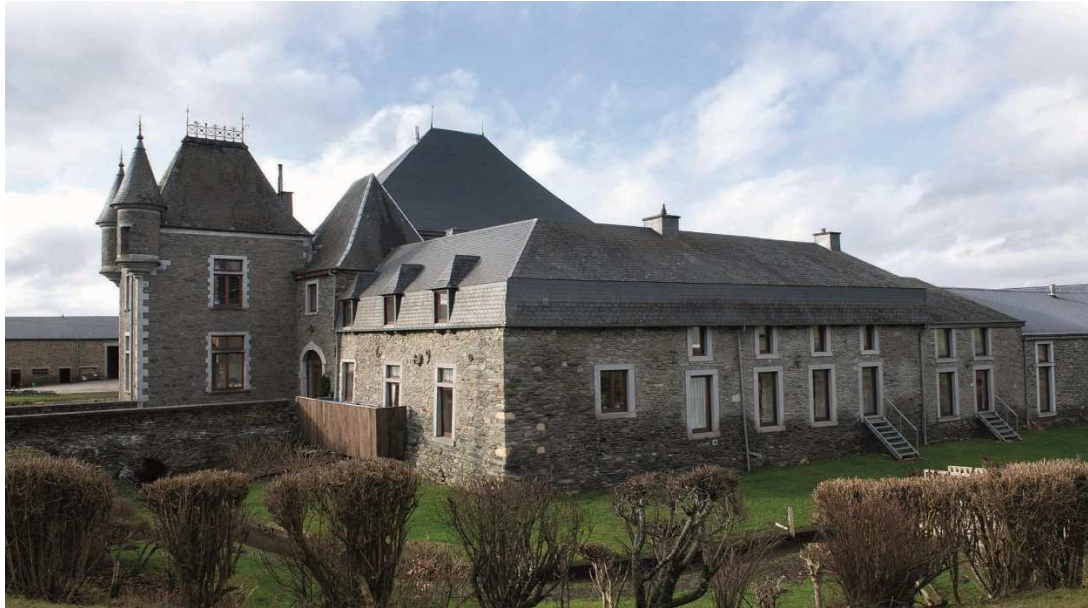
Figure 15 : Le Château-ferme de Laval - Source : parismatch.be
