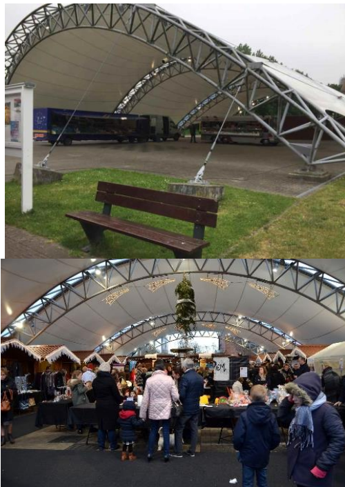
Structure métallique avec toile à Comines
