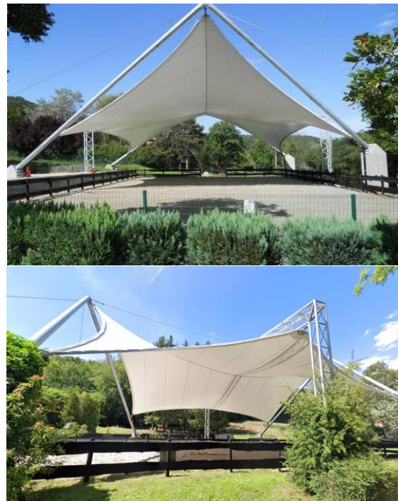
Structure métallique et toile au centre équestre de l'Institut Royal Saint Exupéry
