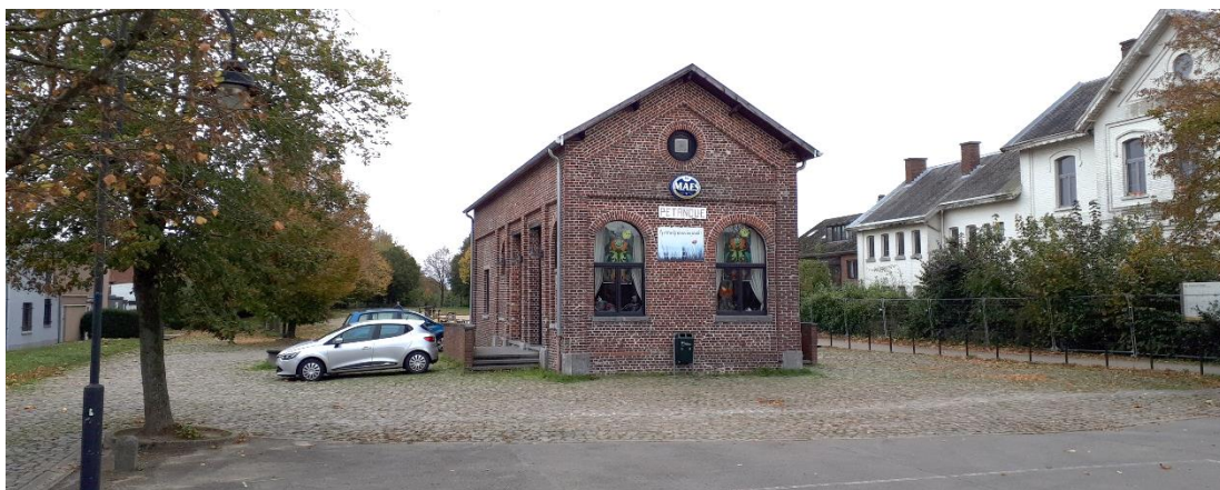
Zone centrale et bâtiment pétanque
