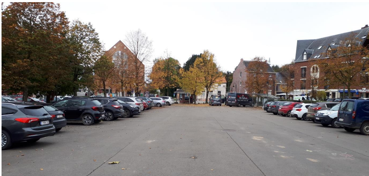
Partie sud, stationnement hydrocarboné
