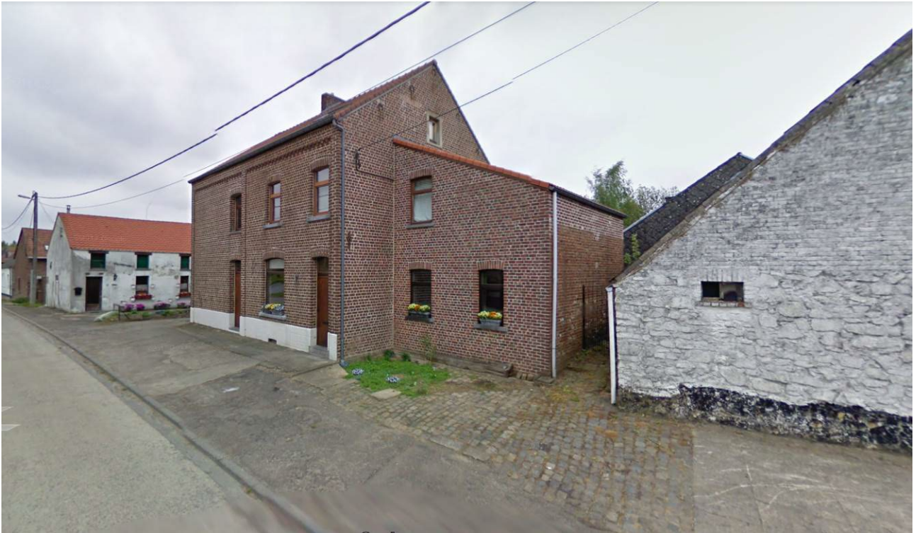
Figure 60 : Exemple de bâti traditionnel - Perwez (Source : Google Street View)
