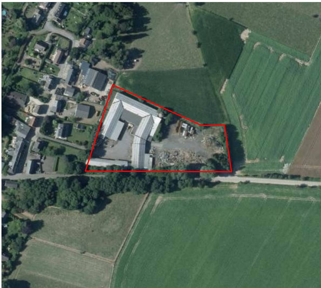
Figure 41 : SAR de fait « Etablissement Coppin » - 2016 (Source : SPW)
