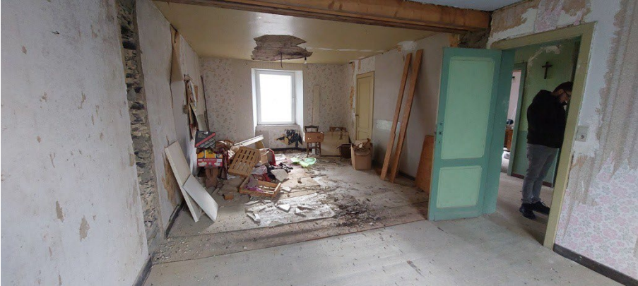
Salle de l'étage
