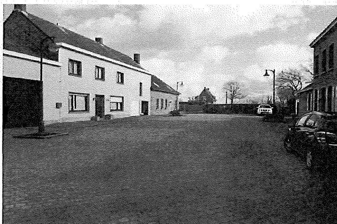
Aménagement de la place de la gare à Russeignies
