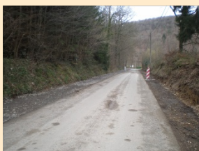
Descente entre Fays et Grand Bru : sécurisation route fossé
