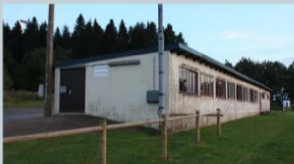
Chemin de Bénasse, ancienne buvette du football, actuelle salle du village
