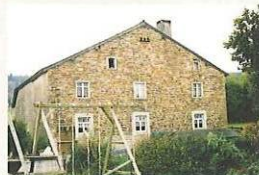
Vôye Louis, 2 Ancienne ferme (habitation) 2 e div., sect. A, 2 e fl le , parc. 619f 19 e et 20 e siècles
