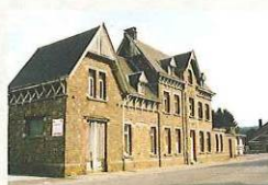
Rue du Vicinal, 18 Ancienne gare (bureaux et dépôt du TEC) 6 e div., sect. A, 6 e fl le , parc. 2025k3, 2025v2 1 er tiers du 20 e siècle 1908-1912 (s)
