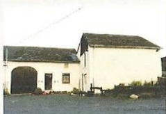
Rue de la Jonction, 16 Ancienne ferme (habitation) 5 e div., sect. B, 1 re fl le , parc. 22b 19 e siècle
