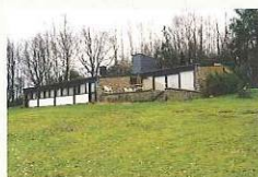
Al Béole, 30 ◇ Habitation 3 e div., sect. B, 4 e fl le , parc. 1170c 3 3 e tiers du 20 e siècle 1971 (s) Architecte Jacques Wauters
