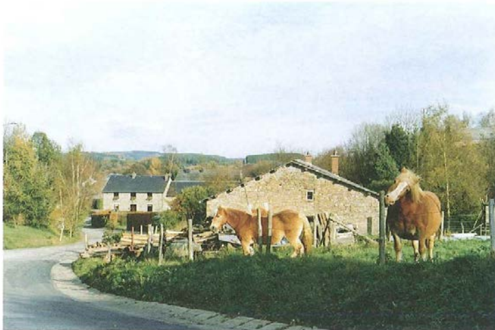
A Bas-Vâ, les caractères ardennais du bâti de Vaux-Chavanne transparaissent dans les volumétries, l'emploi des moellons de grès en maçonnerie et du schiste ardoisier en toiture.
