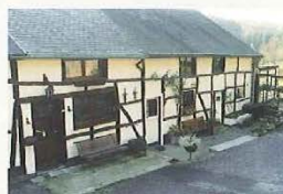
Rue des Deux-Rys, 41 Ancienne maison rurale (habitation) 3 e div., sect. B, 3 e fl le , parc. 1026c 16 e (?), 19 e -20 e siècles
