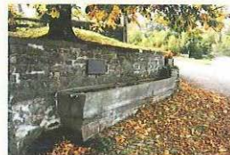
Rue de Montaigu, 8 (en face) Fontaine du Cheyneux Abreuvoir 2 e div., sect. B, 5 e fl le , parc. 719/3 19 e et 20 e siècles 1990 (m)
