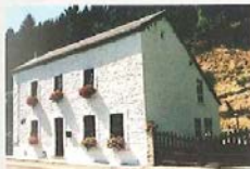
Route de Bomal, 20 Habitation 1 er div., sect. B, 3 e fl le , parc. 1337m 19 e -20 e siècles
