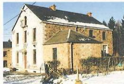
Rue du Pouhon, 2 Ancienne école (habitation) 3 e div., sect. B, 2 e fl le , parc. 162n, 162r, 162z 2 e moitié du 19 e siècle 1860 (s)
