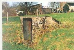
Rue du Manèdje, 1 (en face) Ancien puits 3 e div., sect. B, 2 e fl le , parc. 153g (devant) 19 e siècle
