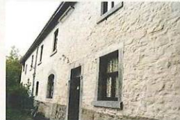
Route de Lamormenil, 4 (lieu-dit Forge-à-la-Plez, hors carte) Scierie Sadzot Anciens moulin, forge, scierie et ferme (habitation et scierie) 1 re div., sect. A, 3 e fl le , parc. 1295e, 1295L, 1299/2, 1299p 18 e , 19 e et 20 e siècles
