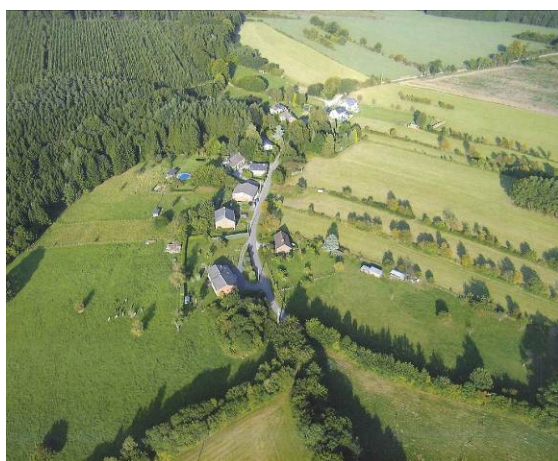
Source : Manhay vue du ciel, Haute Monchenoûle
