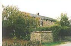
Col de Lamormenil, 31 Ancienne ferme (habitation) 2 e div., sect. A, 2 e fl le , parc. 841d 2 e moitié du 19 e siècle
