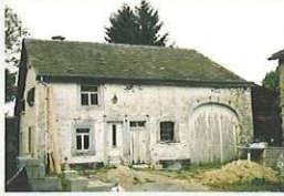
Route des Frères Lamormainy, 38 Ancienne ferme 2 e div., sect. A, 2 e fl le , parc. 767d 2 e moitié du 19 e -1 er tiers du 20 e siècle 1902 (m)
