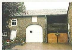
Rue Saint-Martin, 30 Ancienne ferme (habitation) 4 e div., sect. A, 2 e flle, parc. 960L, 960p 19 e -20 e siècles
