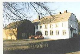
Rue du Manèdje, 21 Ferme du Ménage Ancienne ferme (habitation) 3 e div., sect. B, 2 e fl le , parc. 415m 19 e siècle
