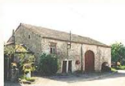
Chemin des Écoliers, 3 Ferme 5 e div., sect. A, 1 er f lle , parc. 63e 19 e siècle et début du 20 e siècle
