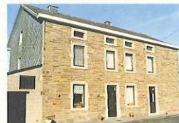
Rue de Sa del Haye, 5 Habitation 3 e div., sect. B, 2 e fl le , parc. 157h 2 e moitié du 19 e siècle
