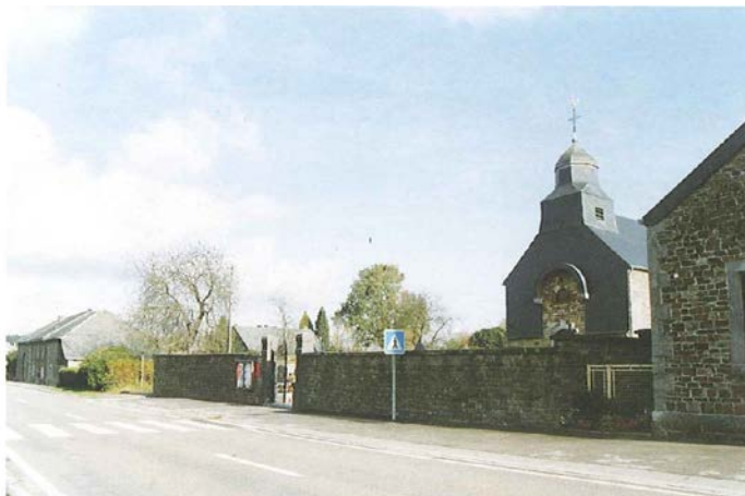
Au long de la grand-route qui mène à Liège se distinguent ici une partie de l’école communale de Chêne-al’Pierre, remontant au dernier tiers du XIXème siècle, l’église paroissiale datée de 1840, dans son cimetière enclos, et plus loin, le gros volume d’une ancienne ferme.
