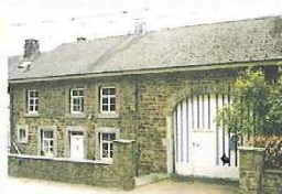
Rue des Deux-Rys, 45 Ancienne ferme (habitation) 3 e div., sect. B, 3 e fl le , parc. 1014b 3 e tiers du 19 e -20 e siècles
