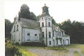
Route de Liège, 19-21 Château 1 re div., sect. C, 2 e fl le , parc. 334e 2 , 334w 2 e moitié du 19 e et 20 e siècles
