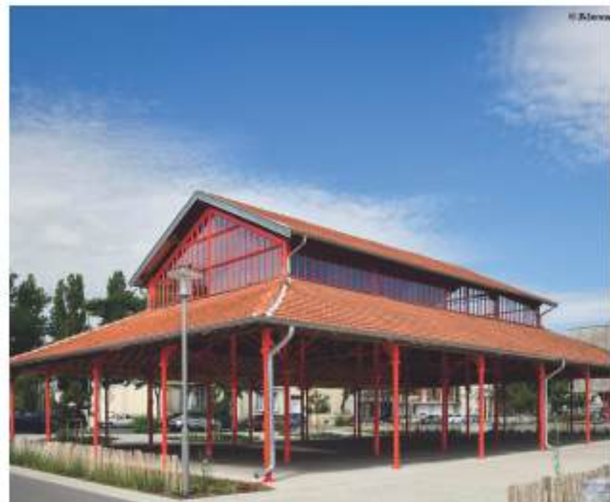
Halle type de marché couvert, avec une forte référence historique afin de marquer l'espace et l'identité de la place.
