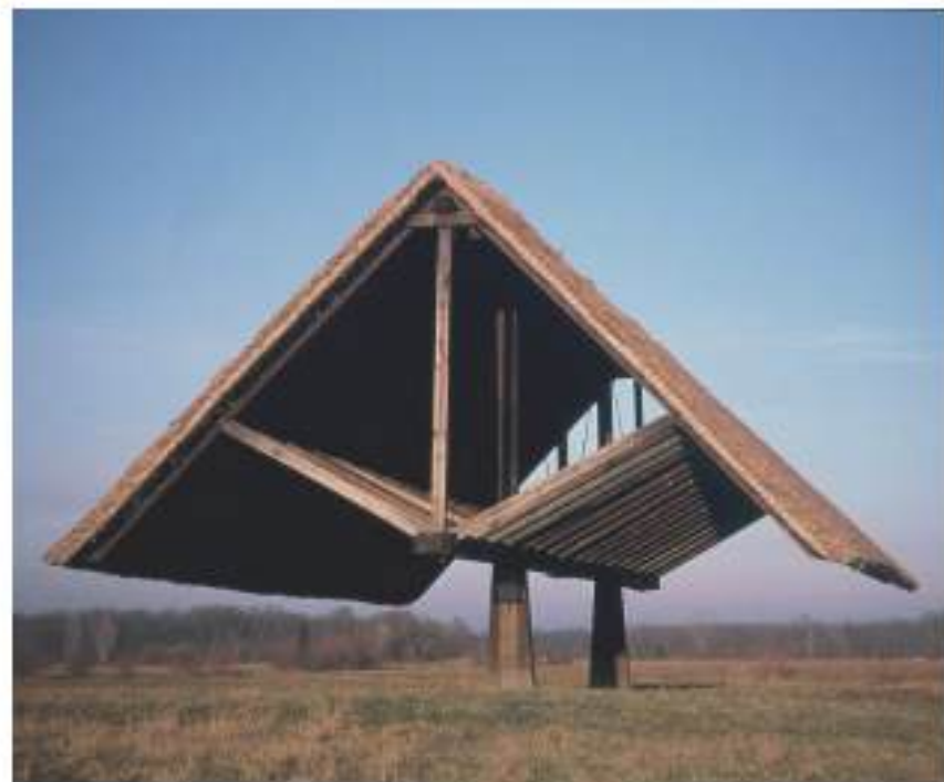
Halle type charpente suspendue qui permet de développer un espace couvert originale et de montrer un savoir-faire local des artisans.
