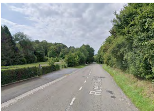
Rue de Vêves – vitesse et état de la route
