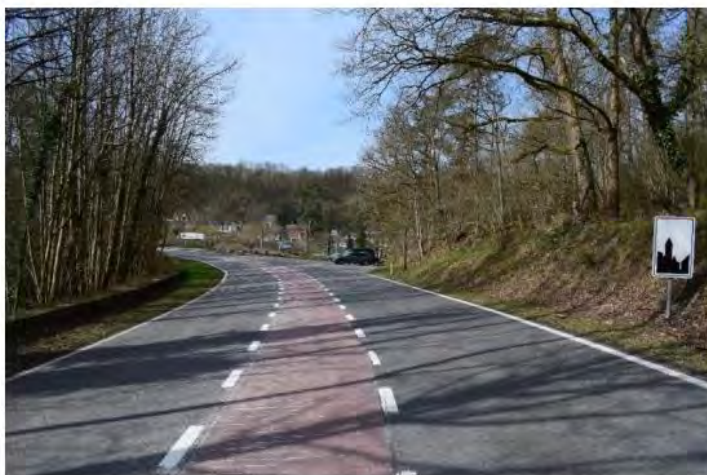
Entrée 2 : Route de Wiesme – Niveau 1
