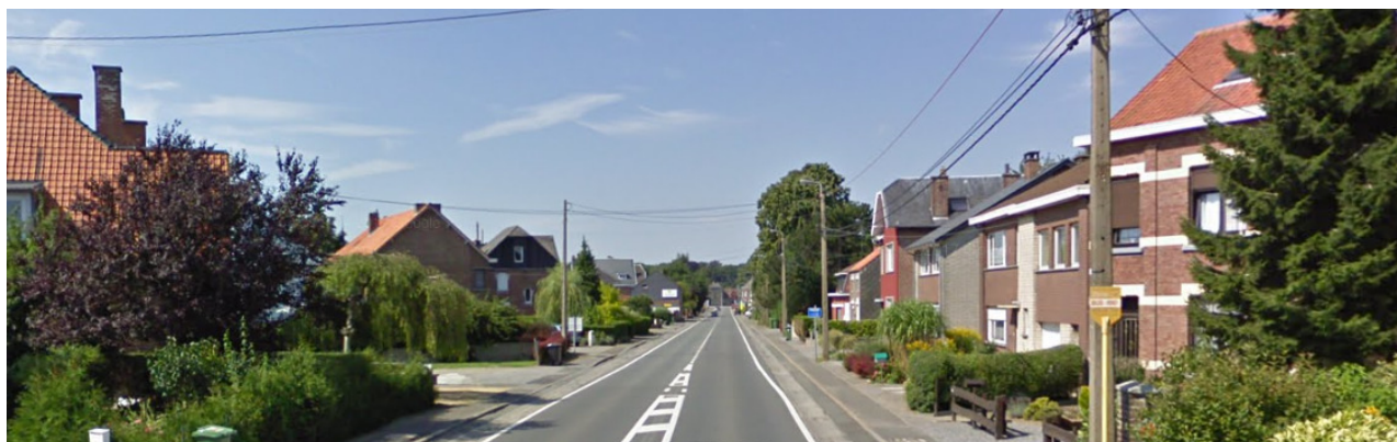
Hannut-centre (Route de Namur) (source : google street view)
