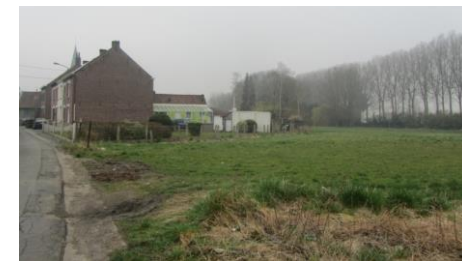
Logements à Saint-Léger
