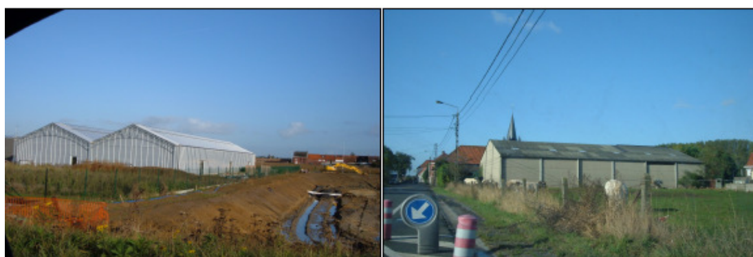
Exemples de PR : Parc économique du Quevaucamps (PR1) et hangar agricole situé rue de Lille (PR7).
