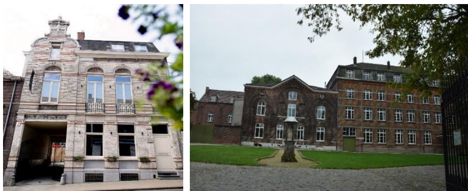
Figure 133 : Hôtel de la Poste – Ancien pensionnat Divine Providence
