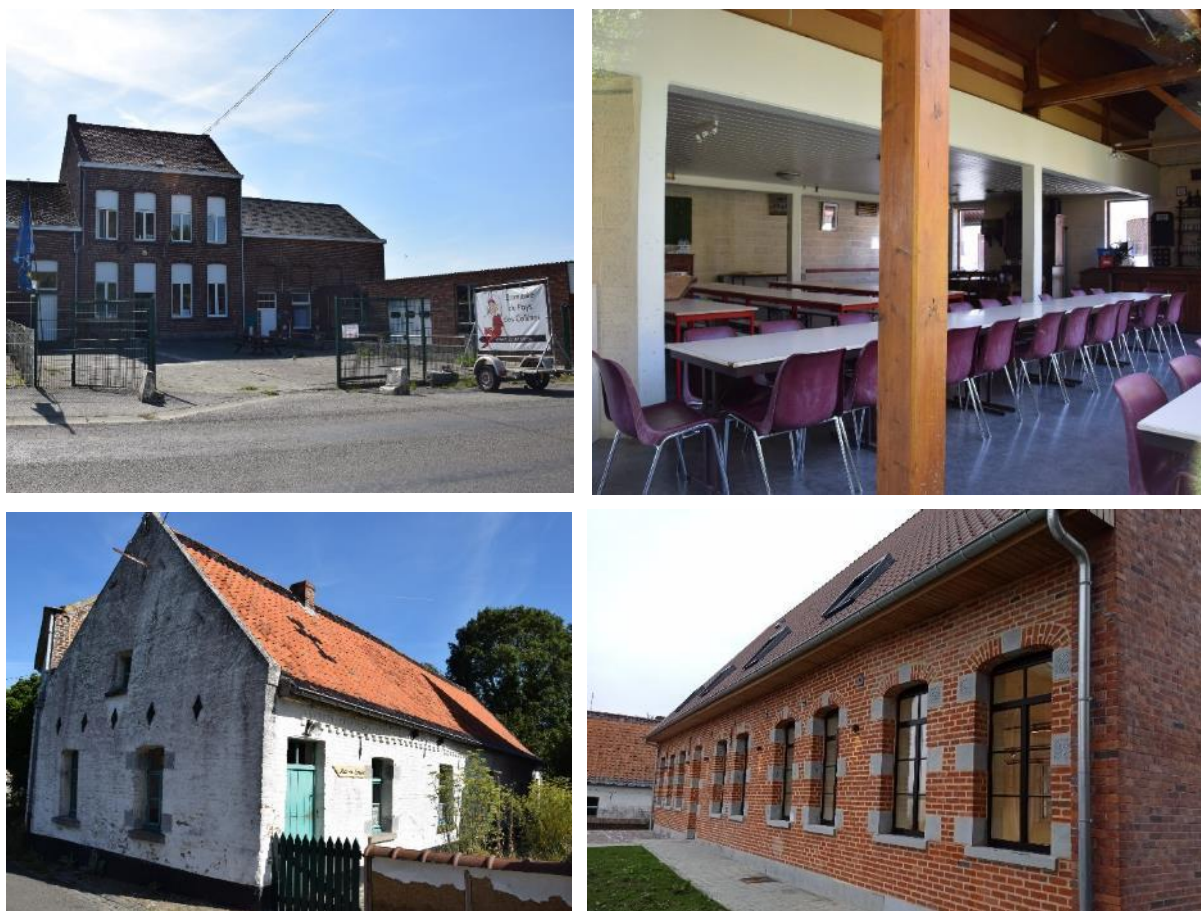
Figure 84 : Ancienne école – salle à l’arrière de l’ancienne cure – Maison Louise – Ancienne cure rénovée (2022)
