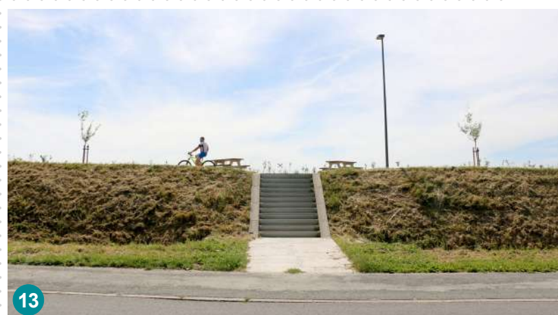
Escalier menant à l'aire de convivialité depuis le parking en bord de voirie avec une rigole pour vélo de chaque côté
