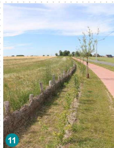
Fascine contre les coulées boueuses
