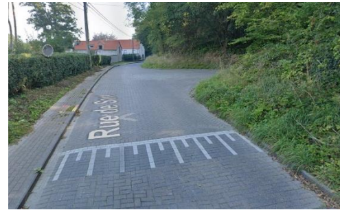
Dispositifs ralentisseurs sur le tronçon 3 de la rue de Sart (source : Google 2021)
