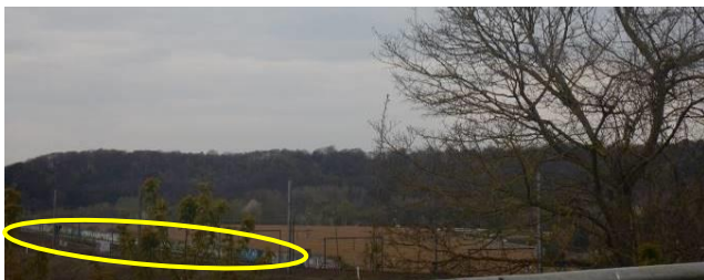
Figure 138: Vue d'infrastructures de chemin de fer depuis le chemin de Grez (AGORA avril 2019)
