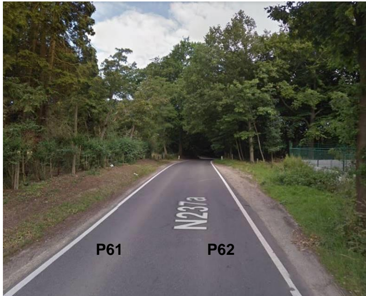
Figure 258 : Section N237a rue de Noirhat (Source : Google Street View)
