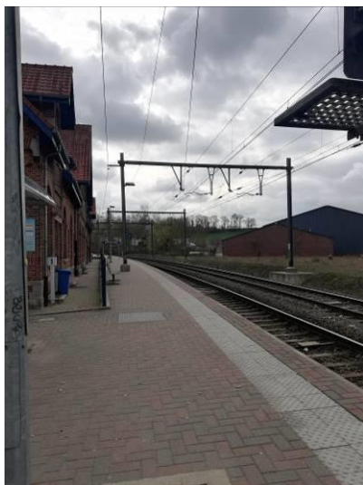
Figure 355 : Gare de Court-Saint-Étienne (Source : Agora)
