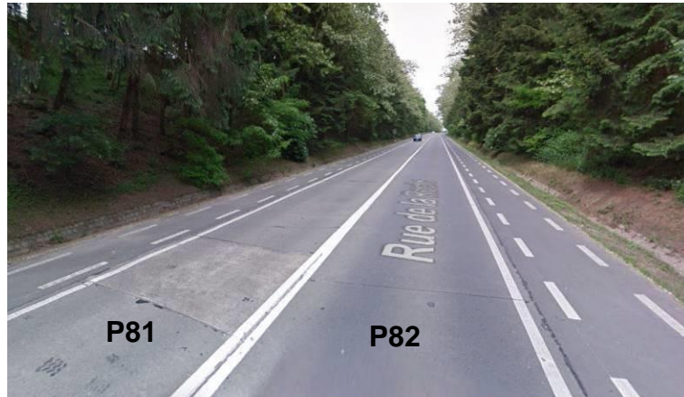
Figure 266: Section N275 rue de La Roche (Source : Google Street View)
