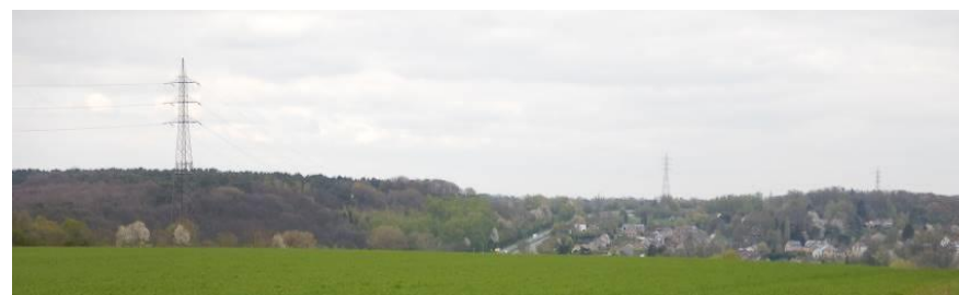
Figure 140 : Vue d'une ligne à haute tension chemin de Nivelles au sud de Beaurieux (AGORA avril 2019)
