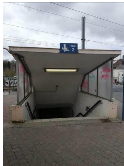
Figure 356 : Passage sous-terrain à la gare de Court-Saint-Étienne (Source : Agora)
