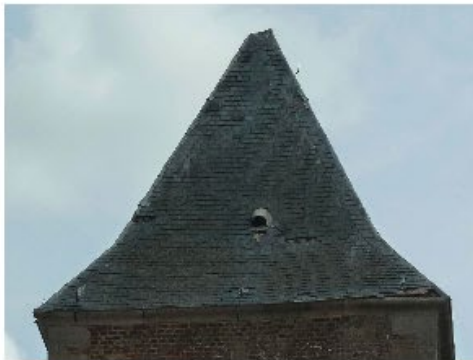
Remplacement de la couverture du clocher
