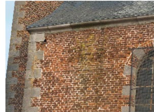
Reprise des eaux pluviales
