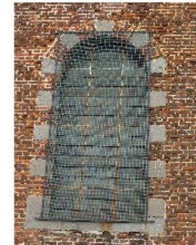
Remise en peinture des éléments métalliques
