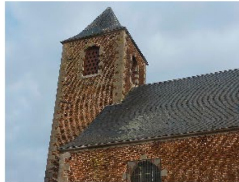
Démoussage et réparations diverses en toiture
