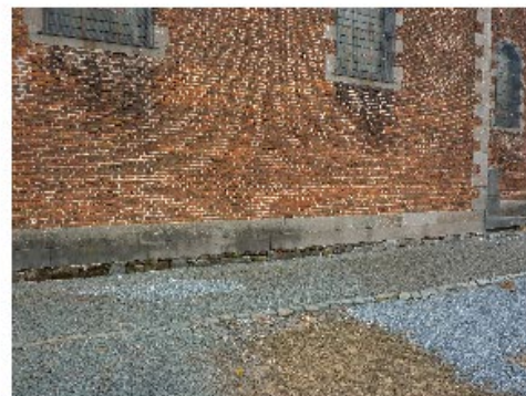
Placement de rejets d'eau en zinc sous les seuils
