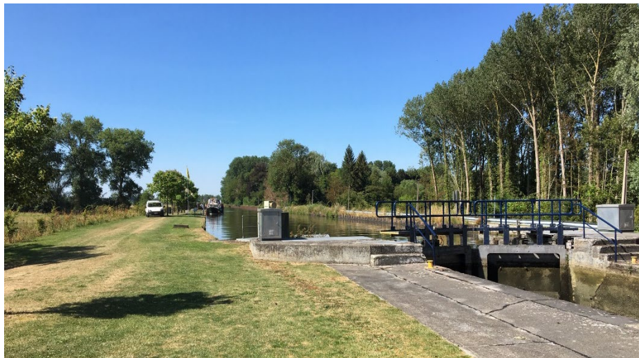
Figure 14 | Relais nautique de Ladeuze, canal Ath-Blaton, écluse n°15 (crédit photo : FRW - août 2019)
