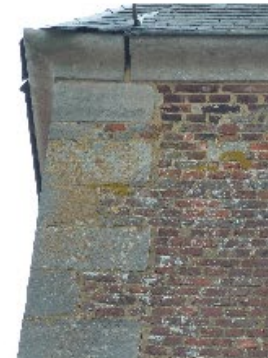
Nettoyage des pierres et réfection des joints
