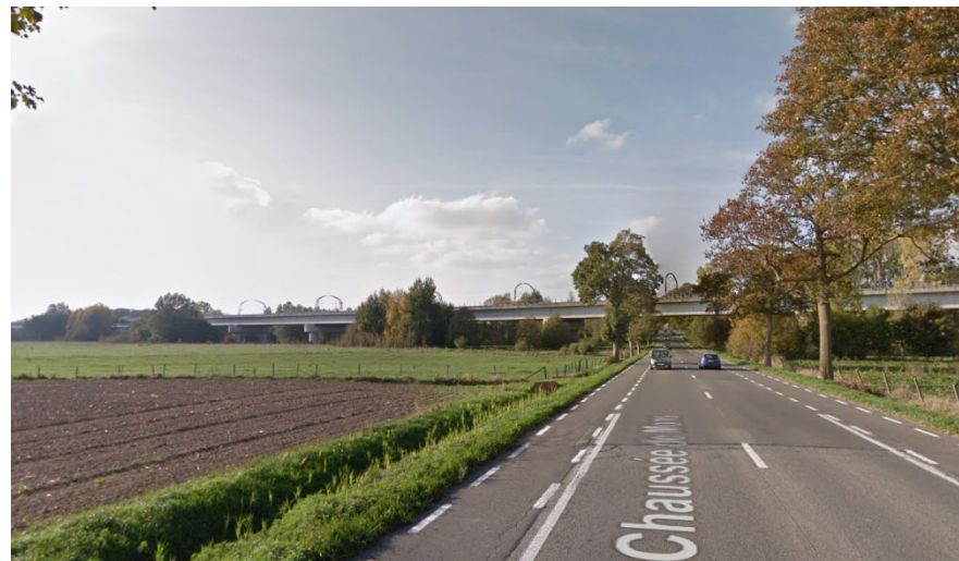
Illustration 20 - Pont ferroviaire de la Ligne à Grande Vitesse
