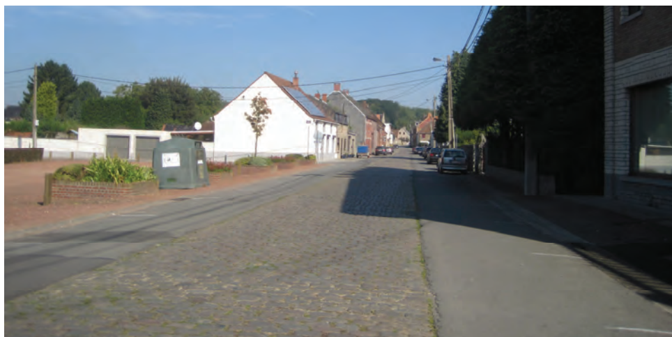
Figure 2: Rue Saint-Gervais et place « rouge » (JNC-AWP)
