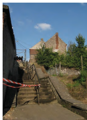
Figure 4: Escaliers – rue du Rocher
