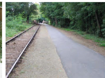
Figure 17: Voie verte des Hauts-de-Tardoir (F) - Limitation du revêtement imperméable et partage de différents modes (Source : http://ffct.org )
