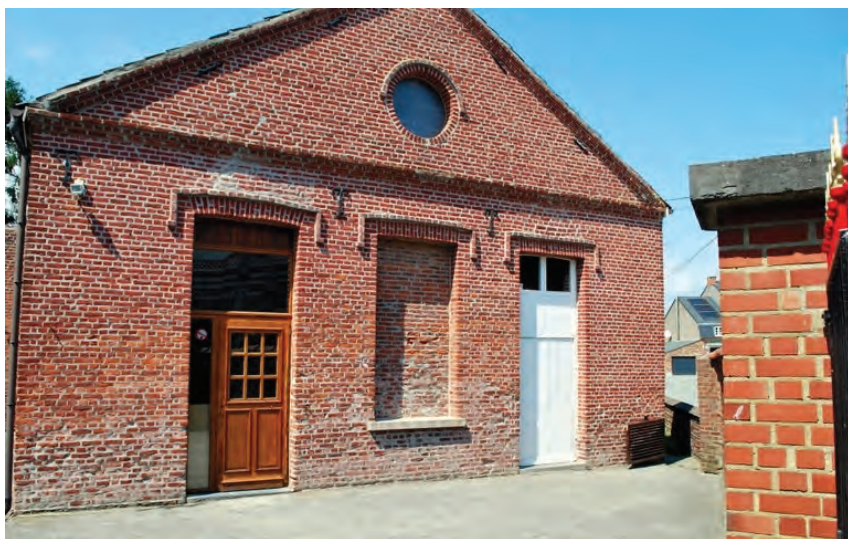
Figure 2: Vue depuis le portail d'accès de la rue des Fours à chaux (AC)
