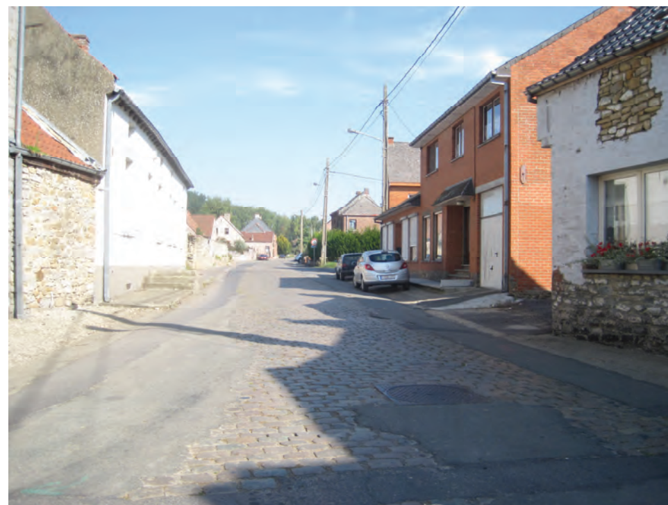
Figure 3: Traversée de village avec revêtement dégradé (JNC-AWP)
