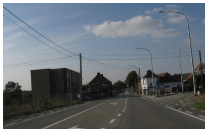
Entrée de commune – N56
