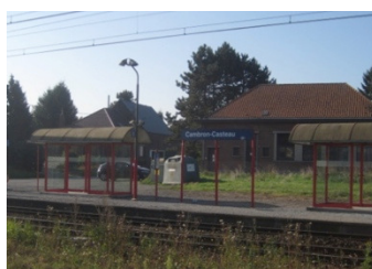
Figure 86 : Gare de Cambron-Casteau (JNC AWP)
