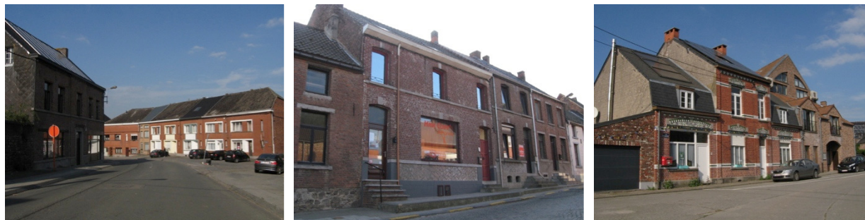
Figure 59 : Exemples d'urbanisation consolidée (de gauche à droite : Brugelette, Cambron-Casteau, Gages) (JNC AWP et Google)
