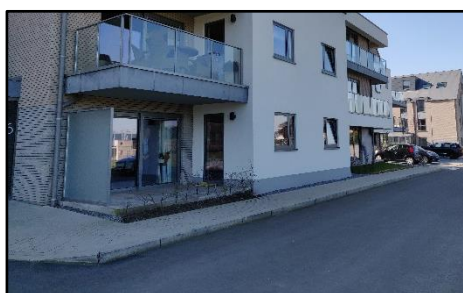
Quartier Les Terrasses
