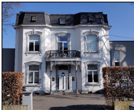
Figure 10.6 Cabinet médical regroupant plusieurs médecins, rue de la Station à Aubel (source : JML, 2019)
