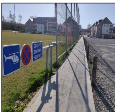
Figure 10.5 Equipement du terrain de football d'Aubel (source : JML, 2020)
