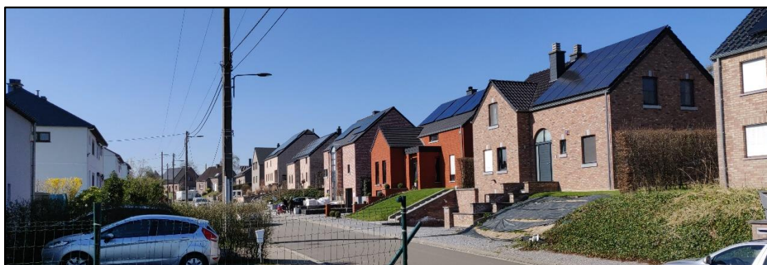
Figure 5.6 Rue Saint Hubert « ensemble 4 » (source : JML, mars 2020)
